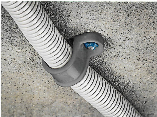
Fig. 9 clemă din plastic tip R-SC40-PCS
